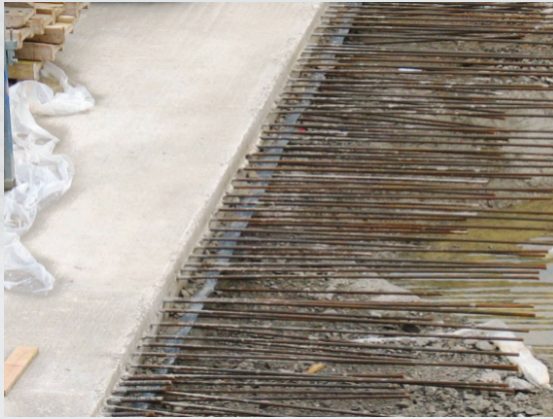
Boden-Bodenverbindung mit TopFuge TF 240
