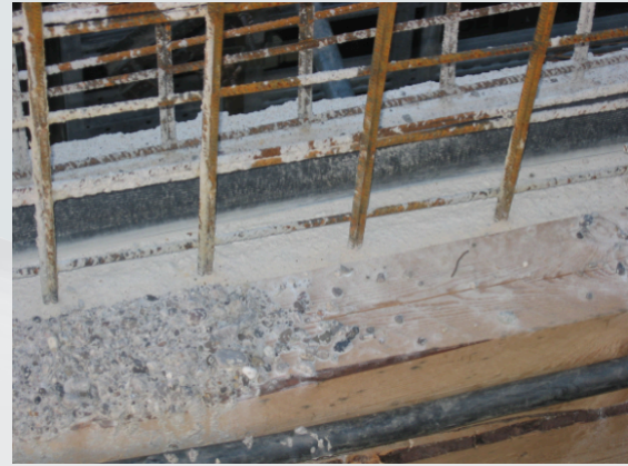
Wand-Deckenverbindung mit TopFuge TF 120
