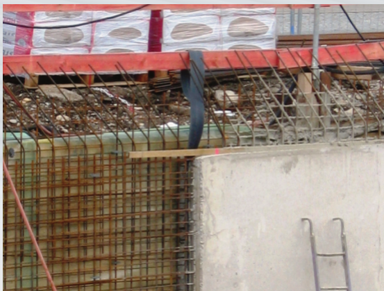
Wand-Wandverbindung mit TopFuge TF 120
