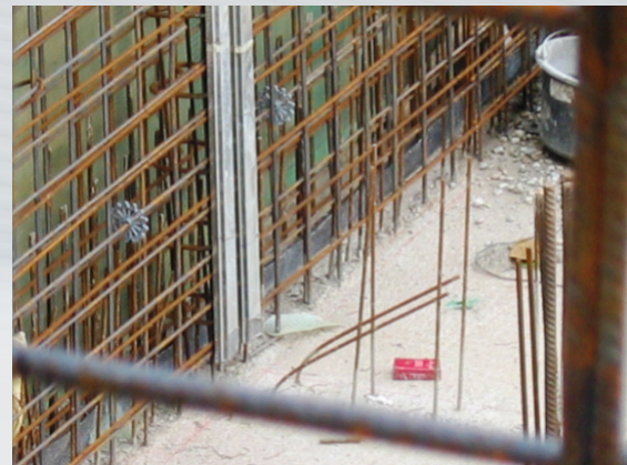
Boden-Wandverbindung mit TopFuge TF 190
